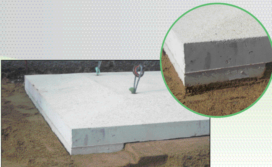
Positionner le ralentisseur sur le sable. Il est très important de veiller à ce qu’il n’y ait aucun espace entre l’inclinaison du talon et le lit de sable.
