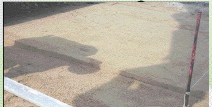
Vue de l’emplacement du talon sur le lit de sable.
