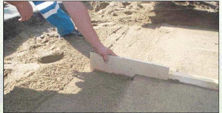
Contrôler la profondeur du talon à l’aide du gabarit qui fait -4 cm.
